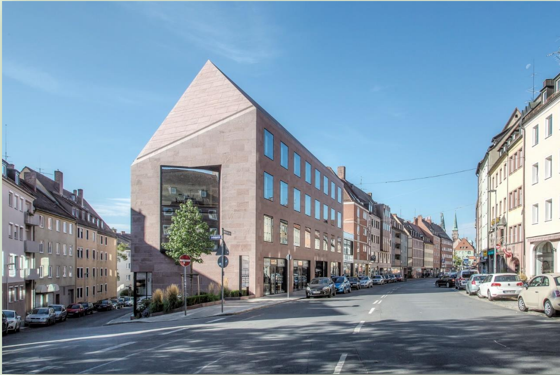
Frei stehende „moderne Architektur“ (stadtraumfoto: Nürnberg) Hier gibt es stadträumliche Indikatoren für die Erregung von Aufmerksamkeit – kein unmittelbarer historischer Kontext wird verunglimpft!
